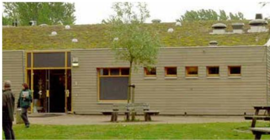
Façade bois et toiture végétalisée, l'image véhiculée respecte un environnement sensible et donne une image qualitative
